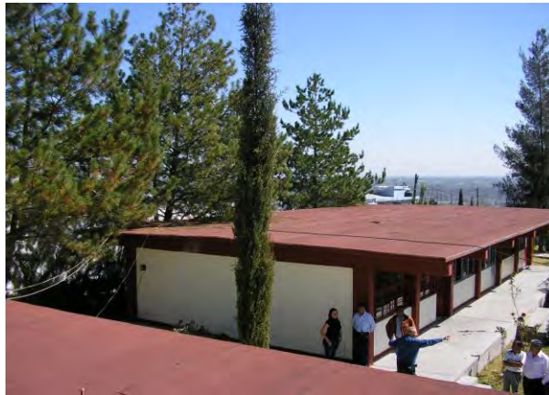
Figura 4.6 Inspección preliminar del exterior del posible sitio de monitoreo.
