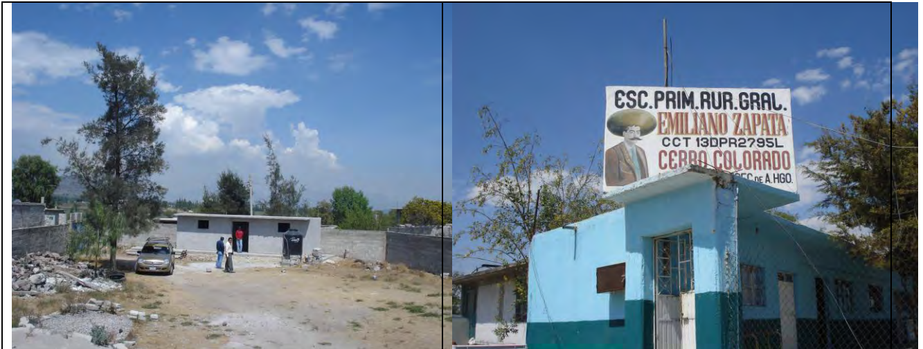
Figura 4.12. Escuela Primaria Emiliano Zapata, comunidad de Cerro Colorado.
