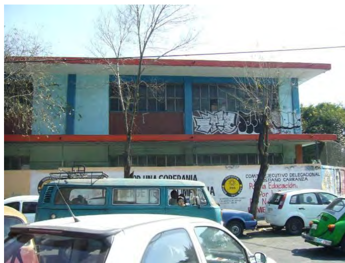
Foto 57: Escuela. Esquina de Eje 1 Norte y Avenida del Trabajo, 5 de enero de 2010. (Foto: CC).
