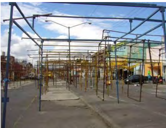
Foto 18: Estructuras metálicas en el camellón de Bartolomé de las Casas 2010. (Foto: CC)
