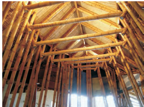
Vista interior de la estructura de guadua
