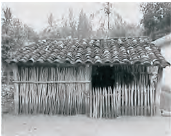
La arquitectura vernácula en el Ejido de Agua Caliente, municipio de Apazapan , Veracruz.
