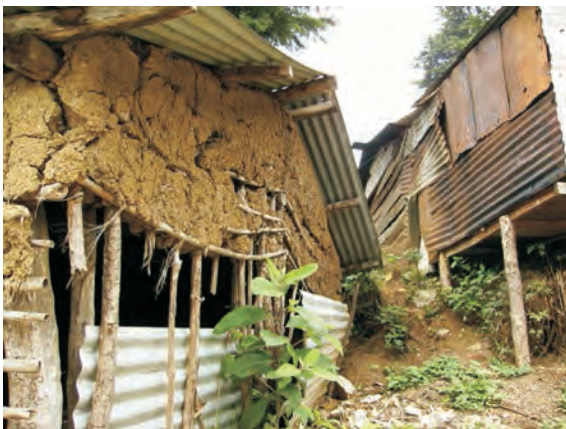
Construcción tradicional en la comunidad de Mitontic (Chiapas), hecha de Bahareque .
