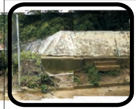
Tanque de agua
