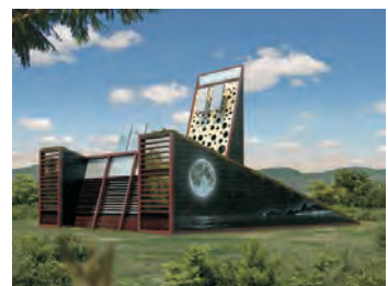
Green Box (Construmat 2009 presenta una Vivienda-Jardín modular, prefabricada, reutilizable, transportable, bioclimática, con consumo energético cero y sin generación de residuos).
