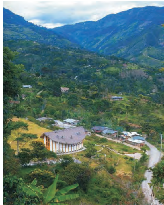
Vista Aérea de la Biblioteca
