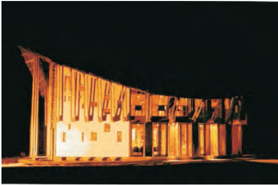
Vista Nocturna Exterior de la Biblioteca
