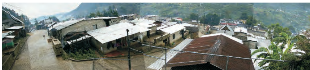
Vista aérea desde el tanque de agua de la comunidad.
