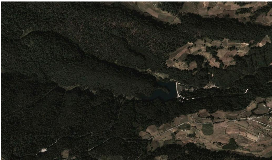
Figura 2. Vista satelital de la Presa el Llano, Villa del Carbón, Estado de México.
