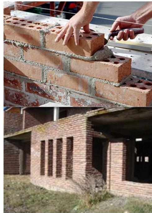
Ilustración 10. Elaboración de muros de tabique mediante el sistema constructivo tradicional. 23
