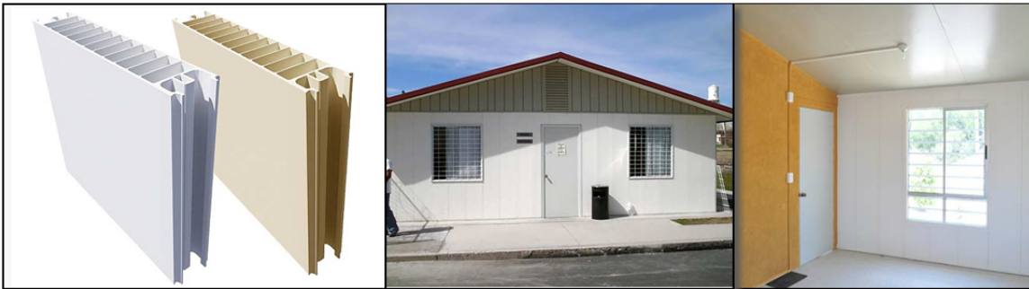
Ilustración 69. Panel de PVC (izq), Vista exterior de la vivienda con este sistema (centro), Vista interior de la vivienda (der) 134
