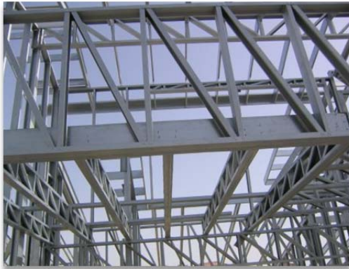
Ilustración 16. Entramado de perfiles de acero galvanizado. 40
