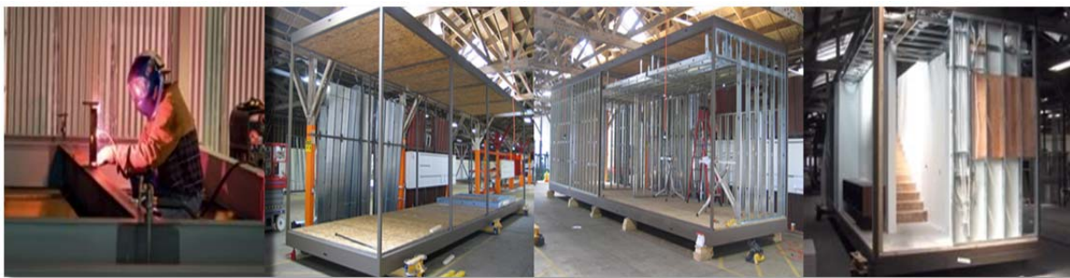
Ilustración 4. Proceso de fabricación de una Vivienda en los Talleres Marmol Radziner. 7
