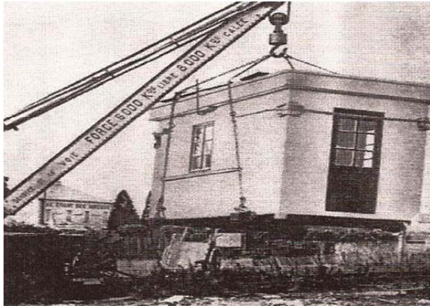
Ilustración 33. Montando una casa Hennebique, 1896. 80
