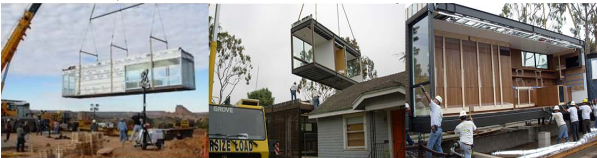
Ilustración 131. Montaje de módulos tridimensionales prefabricados del fabricante Marmol Radziner Prefab mediante grúas de alto rendimiento.
