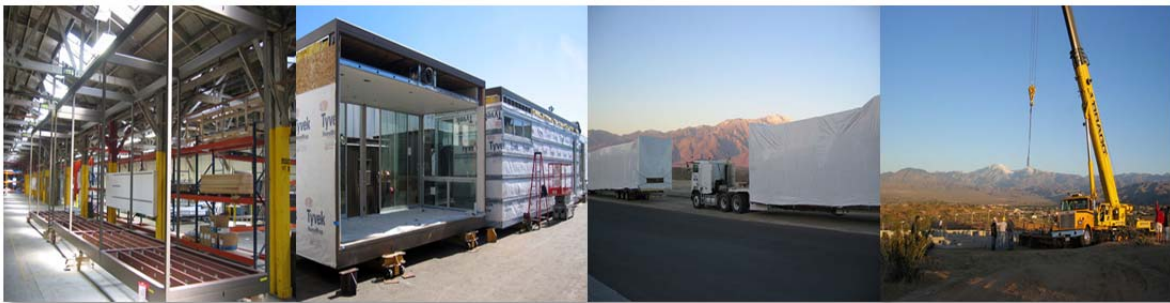
Ilustración 5. Proceso de traslado y colocación de una vivienda prefabricada del despacho Marmol Radziner. 10
