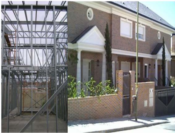
Ilustración 14. (der) Casa en construcción mediante Steel Framing y (izq) misma casa después de la construcción. 34
