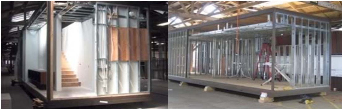
Ilustración 12. Módulos prefabricados a base de steel framing del despacho Marmol Radziner, en California EUA, se aprecia la conjunción del acero estructural en los marcos y el acero galvanizado en muros y cerramientos. 32
