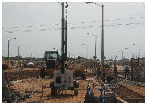
Figura 4.2 Fraccionamiento 27 de Octubre en diciembre del 2010
