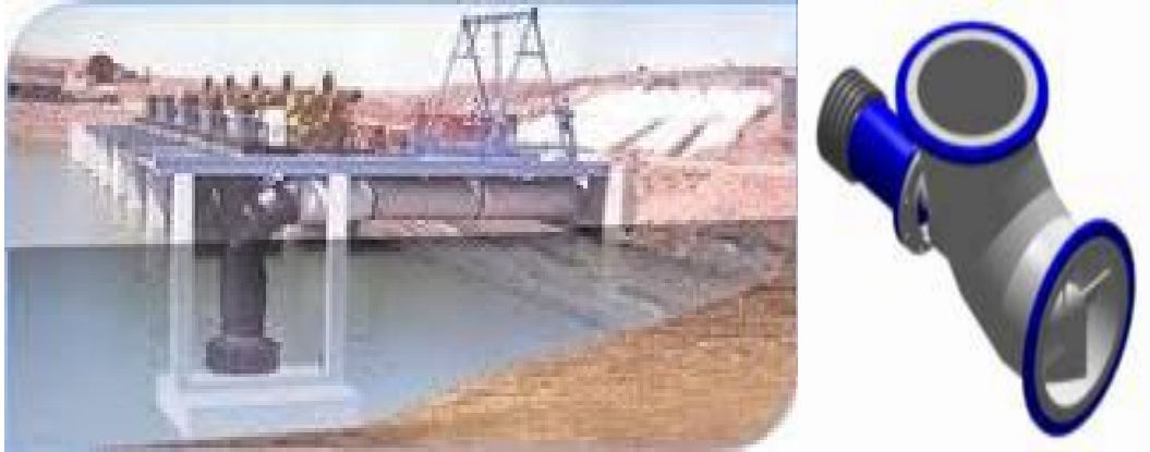
Figura 4.2 Bomba axial de 20", Capacidad de 1000 Lts/seg, A 900 r.p.m 3
