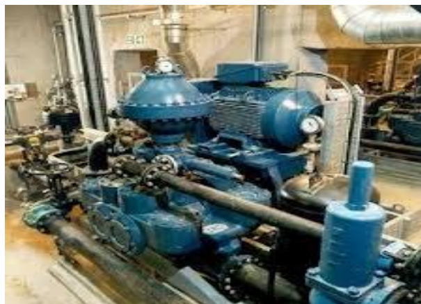
Figura 6.4 Bomba de pistón doble
