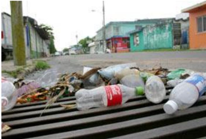
**Fig. 14** Imagen que muestra basura obstruyendo una alcantarilla, una de las causas de inundación.
