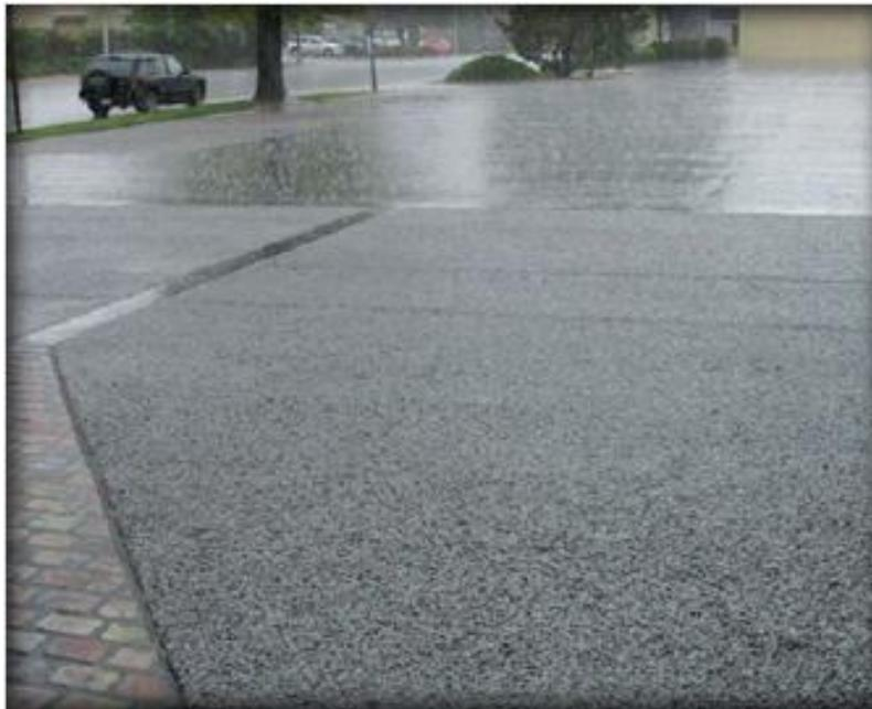
**Fig. 27** Imagen que muestra un sitio permeable a base de un sistema de pavimento poroso, lo que ayudará a reducir el escurrimiento en calles y saturación del drenaje.
