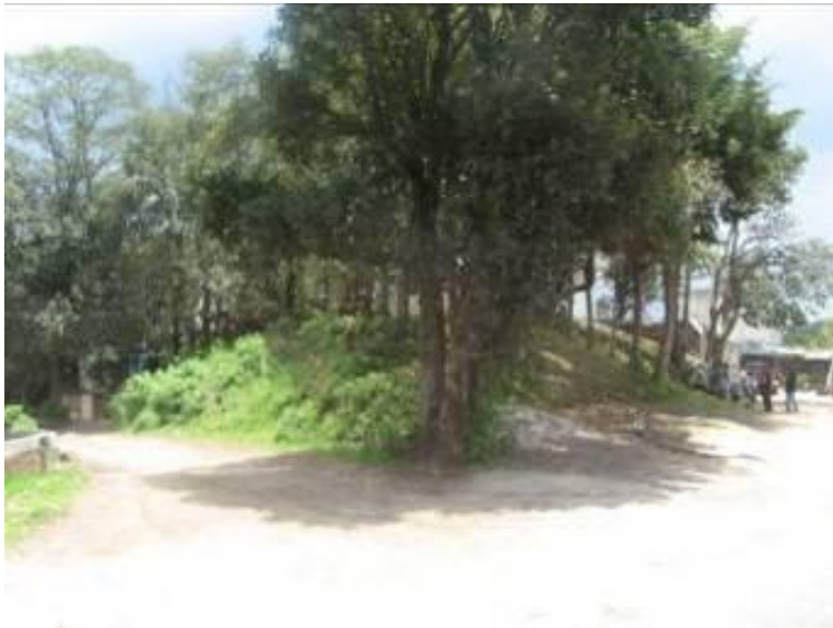
Figura 8. Sitio No. 1. Vista general de la estructura.
