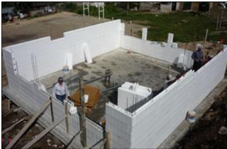
FOTOGRAFÍA 4. Levantamiento con muros ICF
