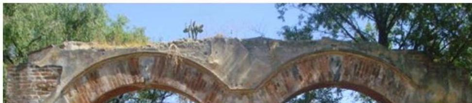
Imagen 1. Vegetación invasora, que ha provocado derrumbes y deterioro a la fachada, tanto el desgaste de los materiales así como derrumbes de la propia fachada, debe darse un tratamiento para eliminar y poder restaurar el edificio
