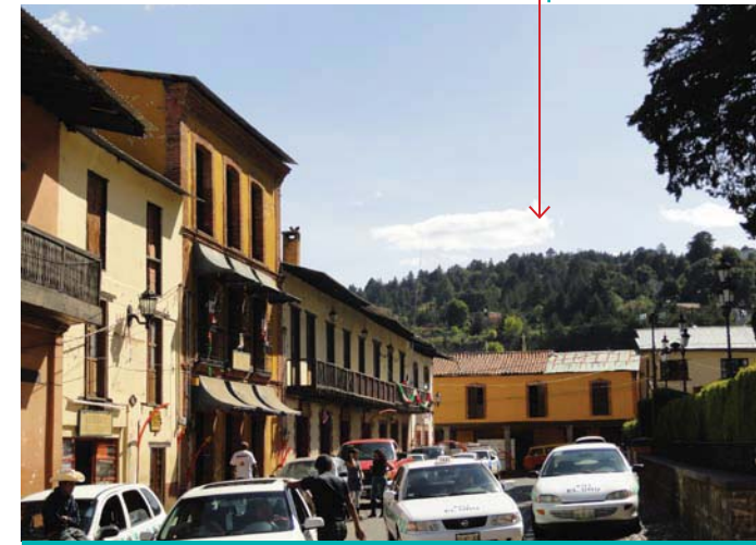
Figura 95. Jardín principal de “El Oro”, los inmuebles entorno a él, aún se conservan con algunas modificaciones como el retiro de los barandales y balcones; sin embargo, alteraciones más significativas que sufrió la población fue la pérdida de las instalaciones industriales. Foto: N. Tepox P. 2011.
