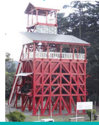
Figura 103. Tiro Norte reconstruido, acciones que se llevan a cabo para el rescate del patrimonio industrial que se conserva en “El Oro”. Foto: N. Tepox P., 2012.
