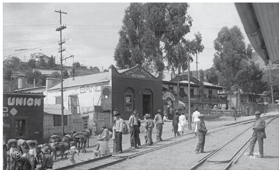
Figura 80. Vista del Hotel Jardín y el salón Roma (restaurante del hotel) desde la estación del ferrocarril. En la imagen se manifiesta la relación que existió entre el ferrocarril y el hotel así como el contraste de la población que se dirige a él con los campesinos residentes en la población. A la fecha de la toma, aún aparece el segundo piso del edificio central del hotel. Las construcciones a los costados del mismo ya no existen en la actualidad. Fuente: @121595. CONACULTA.INAH.SINAFO.FN.MÉXICO. Ca. 1910.
