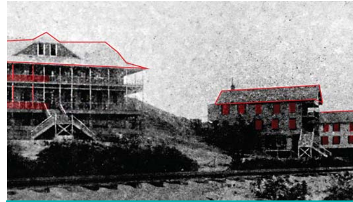
Figura 43. Oficinas generales de la Compañía del ferrocarril de Tehuantepec, en la imagen se puede ver que las construcciones fueron grandes naves de madera con vanos repartidos a lo largo de ésta y techos inclinados con laminas de zinc.
