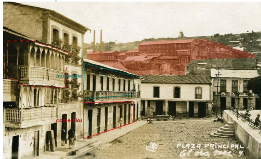
Figura 79. Vista de la plaza principal de "El Oro" donde se encuentra "Hotel Gran Sociedad". En esta imagen también se observa en planta baja la parte comercial y en planta alta las habitaciones del hotel. También se puede ver que la imagen urbana del lugar lo constituyeron inmuebles de dos y tres niveles. Destacan los andadores perimetrales con columnas y barandales de madera. Al fondo se observan las instalaciones de "El Oro Mining & Railway Co.". Actualmente se conservan los inmuebles que circundan el Jardín principal, todos mantienen su vocación comercial y solo algunos han sufrido alteraciones como la pérdida de los balcones y los edificios industriales han desaparecido. Fuente: Archivo personal Víctor Sánchez, s/fecha.
