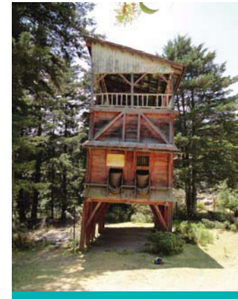
Figura 102. Tiro Norte antes de la intervención. Foto: N. Tepox P. 2010.
