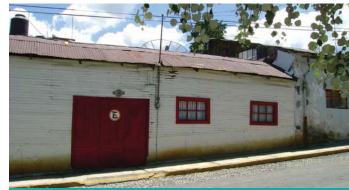
Figura 96. A pesar de la destrucción que sufrieron a partir de los años treinta a las construcciones típicas de la población fabricadas con muros de madera y techos a dos aguas con láminas de zinc. Es posible encontrar algunas dentro polígono de protección del centro históricos y en las colonias donde anteriormente existieron barrios obreros. Foto: N. Tepox P. 2011.
