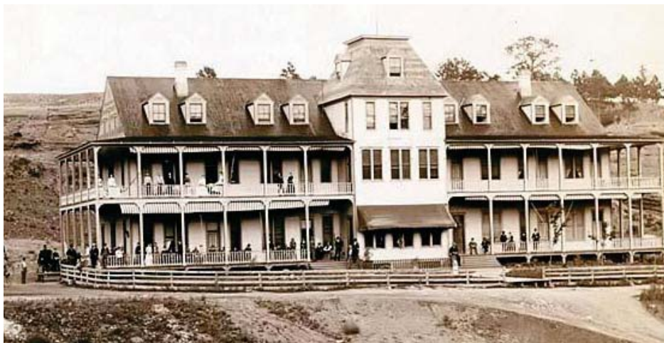
Figura 84. Hotel en los Estados Unidos Ca. 1910, de la construcción destacan los andadores perimetrales con barandales y columnas de madera y las techumbres inclinadas. Fuente: www.fliker.com
