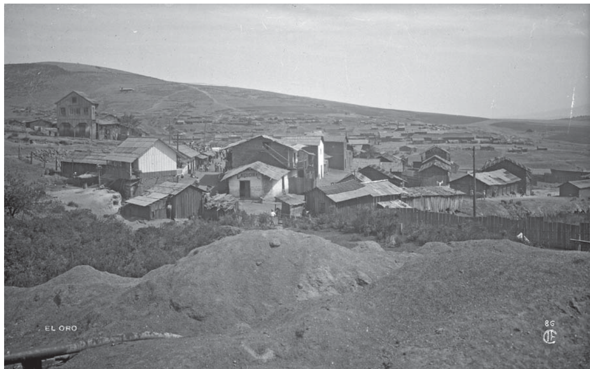
Figura 12. Esta imagen nos muestra un barrio de trabajadores mineros de "El Oro", el cual conforma un gran caserío de construcciones fabricadas con muros de madera, con cubiertas a dos aguas de tejamanil; también se pone en evidencia la arbitrariedad con la que se establecieron las casas y comercios, que obedeció a las condiciones topográficas propias de las poblaciones mineras. No obstante que esta imagen es de 1920, nos da una idea clara de cómo pudieron ser los primeros asentamientos y cómo estas características se mantuvieron hasta entrado el siglo XX, cuando a causa de la decadencia fueron abandonados y desaparecieron. Fuente: © 121592.CONACULTA.INAH.SINAFO. FN.MÉXICO.
