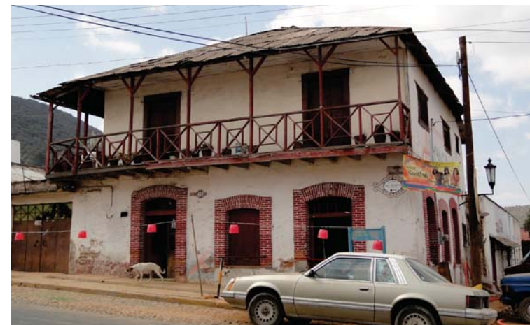
Figura 47. Comercio localizado en la avenida Benito Juárez de "El Oro", en este inmueble se pueden observar las características de esta tipología arquitectónica como son la techumbre inclinada con lámina de zinc; el andador perimetral para entrar a las habitaciones de la planta alta; enmarcamientos de tabique en los vanos, así como las columnas y barandales de madera en el balcón. Foto: N. Tepox P., 2012.
