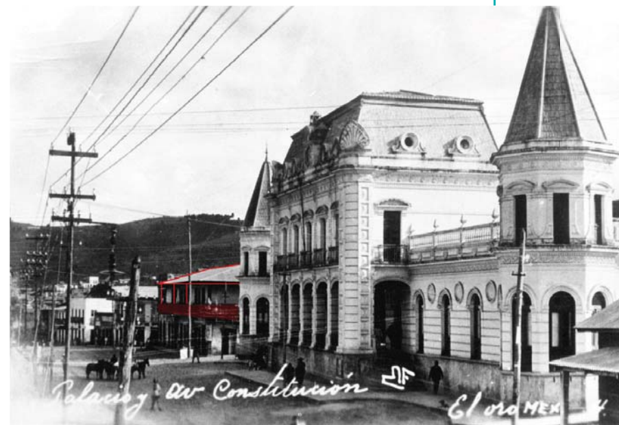
Figura 65. Segundo Palacio Municipal ubicado en avenida Constitución. Este inmueble fue concebido bajo los preceptos de la arquitectura ecléctica con marcada influencia francesa presente en elementos como la mansarda y los torreones de las esquinas. Este inmueble fue objeto de trabajos de restauración en el año 2010. Fuente: Archivo personal de Victor Sánchez. Ca. 1910
