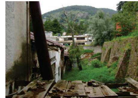
Figura 122. Pérdida de duela y tablonces de madera en entpiso a causa del intemperismo. Presencia de micro-flora parásita en muros. Oxidación en elementos metálicos.
