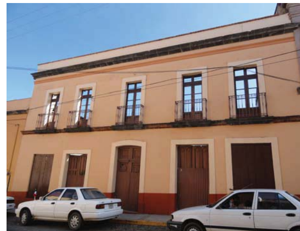
Figura 108. Del inmueble albergó al hotel "La Valenciana" junto al banco de El Oro, sólo se conserva la fachada. En 2011, se les dio remozamiento a las fachadas de avenida Independencia, incluida la de este inmueble. Foto: N. Tepox P., 2011.
