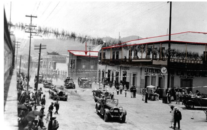
Figura 55. Avenida Constitución, una de las calles principales y donde se localizaron una gran cantidad de locales comerciales que en su mayoría de dos niveles, algunos completamente de madera y otros mezclando en su sistema constructivo, muros de carga de mampostería y adobe con estructura en entresijos y techumbres de madera con lámina de zinc. Destaca el edificio de "La Colmena" que muestra -entre otras cosas- un pasillo perimetral a la construcción con barandales en planta alta y columnas de madera. Al mismo tiempo se aprecia la gran cantidad de personas que se encuentran en las calles, lo nos muestra que "El Oro" fue un centro comercial importante. A excepción del inmueble señalado las demás construcciones permanecen con alteraciones como el retiro de los andadores perimetrales. Fuente: Archivo personal de Víctor Sánchez. Ca. 1920.
