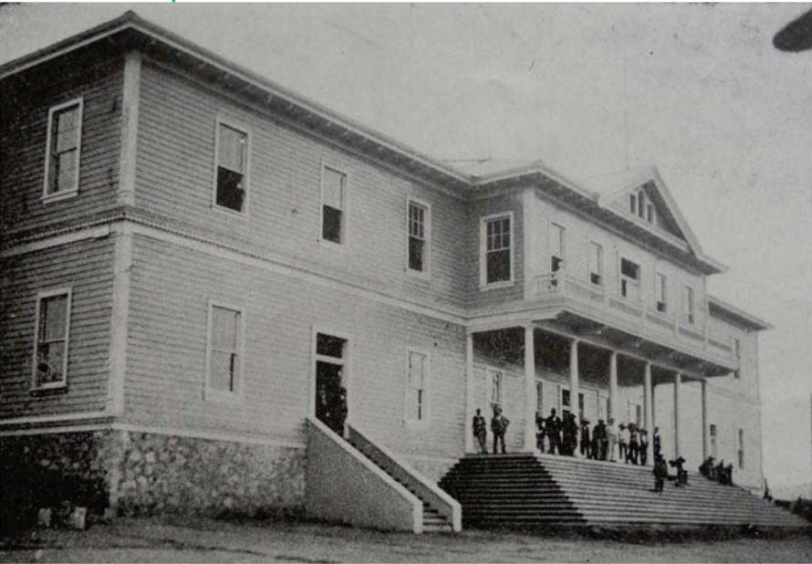
Figura 63. Primer Palacio Municipal de "El Oro". Construcción con muros de madera desplantado sobre un rodapié de mampostería; techos inclinados por la armadura de madera. Destaca el pórtico que enfatiza el acceso con columnas de madera. En la imagen se aprecia que no existen construcciones en torno al inmueble. Fuente: El Palacio Municipal de El Oro en El Mundo Ilustrado , Año VIII – Tomo I. México: 16 de junio de 1901.
