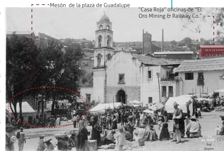
Figura 32. Vista de la plaza Guadalupe donde aparecen la iglesia, la casa cural y al fondo las instalaciones industriales de "El Oro Mining and Railway Co." en el conjunto destaca La Casa Roja (de los últimos vestigios industriales que se conservan actualmente en "El Oro"). Se distingue que a la fecha de la toma no se ha construido la segunda torre a la iglesia. Por otra parte sobresale, el contraste social de la población de la localidad, mientras que en el Jardín central y las calles principales se encontraron instalados los mejores comercios y servicios aquí se concentraron mayormente los campesinos y obreros. También se alcanza a apreciar a un costado del templo uno de los dos mesones que atendieron a los viajeros desde el siglo XIX. Fuente: Archivo personal de Noé Gaytan. Ca. 1910
