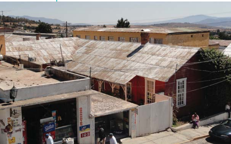
Figura 50. Casa de uno de los comerciantes más importantes de "El Oro" durante el porfiriismo. Este inmueble de un nivel se localiza a un costado del Palacio Municipal, empleó en su construcción los materiales al alcance del lugar como lo fueron la madera y las láminas de zinc. Se observa que la disposición es en forma de "L" entorno a un patio central con cobertizo enmarcado con columnas de madera y canalón de lámina de zinc. 2011
