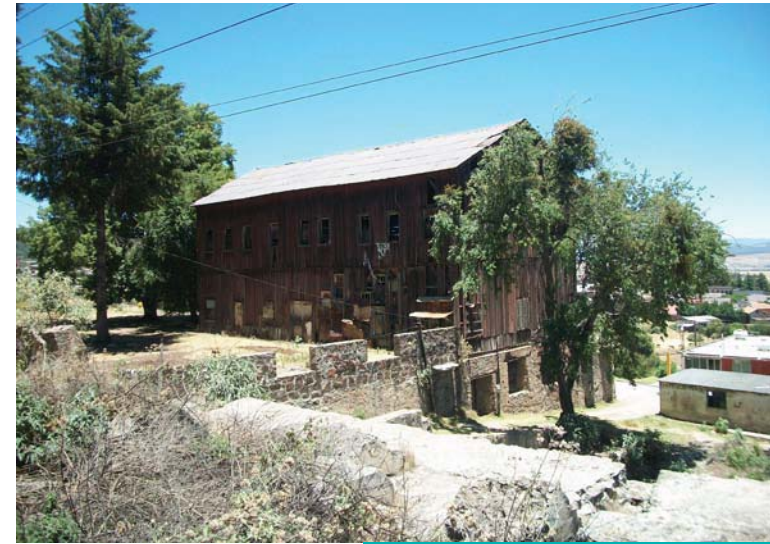
Figura 92. Casa Roja. Antigua oficina de “El Oro Mining & Railway Co.”, constituye uno de los pocos ejemplos de arquitectura industrial que permanecen en la población. Actualmente se encuentra sin uso y expuesto a la degradación; pese de la apariencia de la madera que recubre el exterior, el inmueble por dentro se encuentra en buen estado de conservación. Foto: N. Tepox, 2011.
