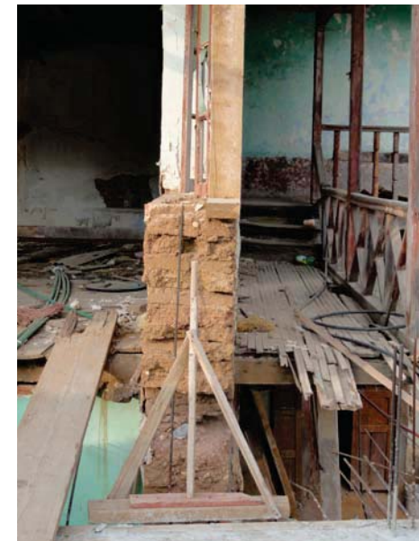
Figura 116. Detalle del muro y estructura de entrepiso del "Hotel Palacio de Cristal"
