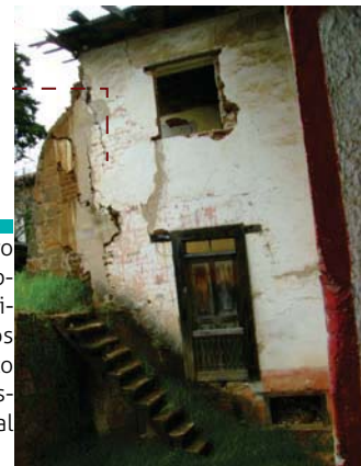
Figura 122. Pérdida de duela y tablonces de madera en entpiso a causa del intemperismo. Presencia de micro-flora parásita en muros. Oxidación en elementos metálicos.
