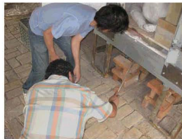
Puerta entreabierta para salida de humedad y se suba la temperatura
