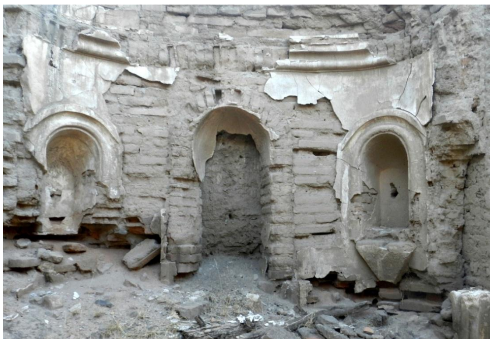
En esta fotografía se observa el interior de la iglesia, en la que los seráficos utilizaron diferentes materiales y técnicas para modificar el espacio del inmueble; arcos y muros de tabique, sobremuros del mismo adobe, estucados y finalmente una bóveda. (Fotografía del autor, febrero de 2012)
