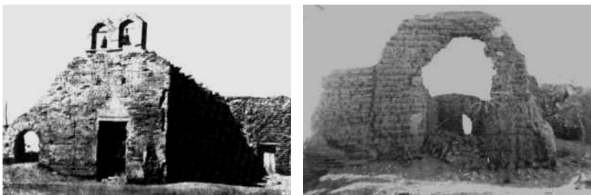
Misión de Atil, en las que además del deterioro, se puede ver como elemento básico de la composición de la fachada, la espadaña, otro elemento de la influencia franciscana utilizada de manera muy similar a las iglesias de Nuevo México y claro también europea. (Fuente: Arizona Historical Society. Southern Arizona Division).
