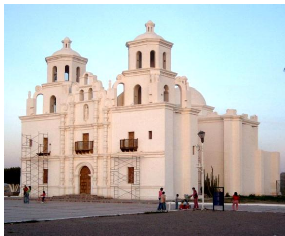
Misión de Caborca (Fotografía del autor, febrero de 2011). La traza y dimensiones de la iglesia de san Xavier del Bac es muy semejante a la de Caborca, por haber sido construida por el mismo maestro albañil Ignacio Gaona con las mismas características constructivas de ladrillo. Aunque su orientación es distinta, la iglesia de San Xavier presenta su entrada principal hacia el sur y Caborca hacia el oeste.
