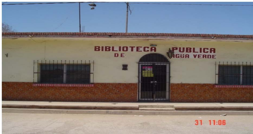
Foto 9. Fachada de la Biblioteca Pública de Agua Verde.
