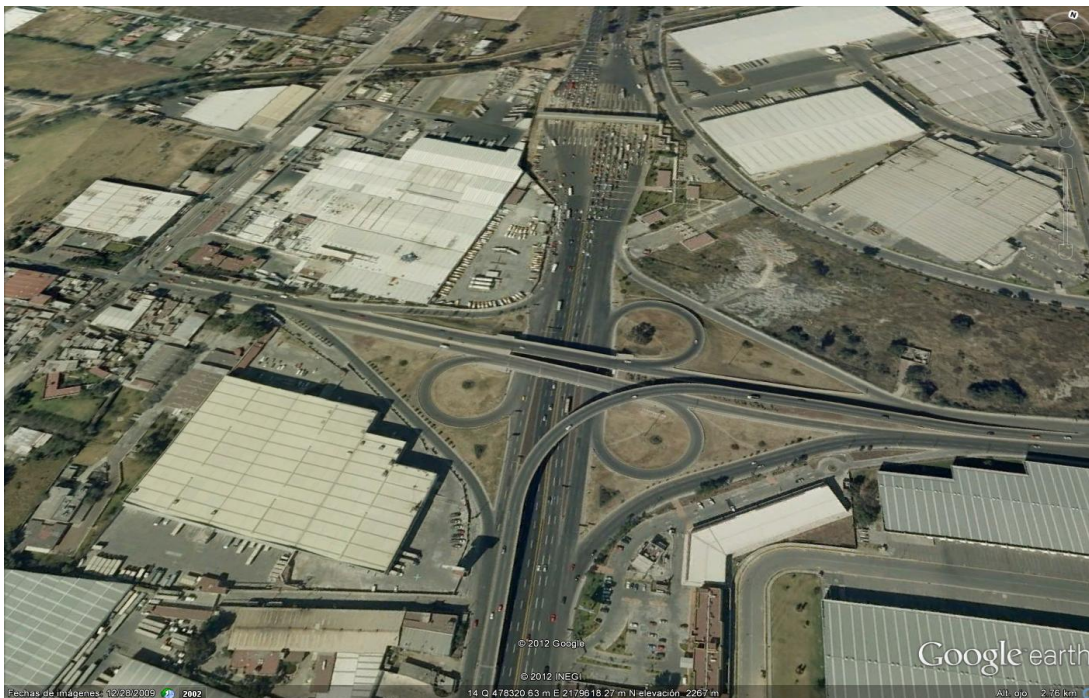
Figura C.4. Vista de red vial y ocupación industrial a la altura de la caseta de cobro de entrada a Ciudad de México.
