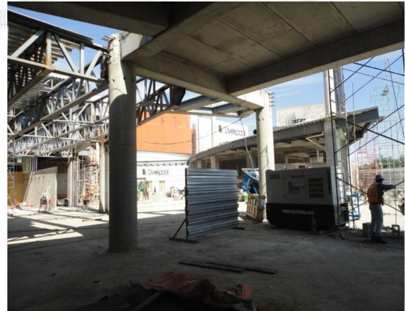
Armadura metálica ligado a una estructura de spancrete.
