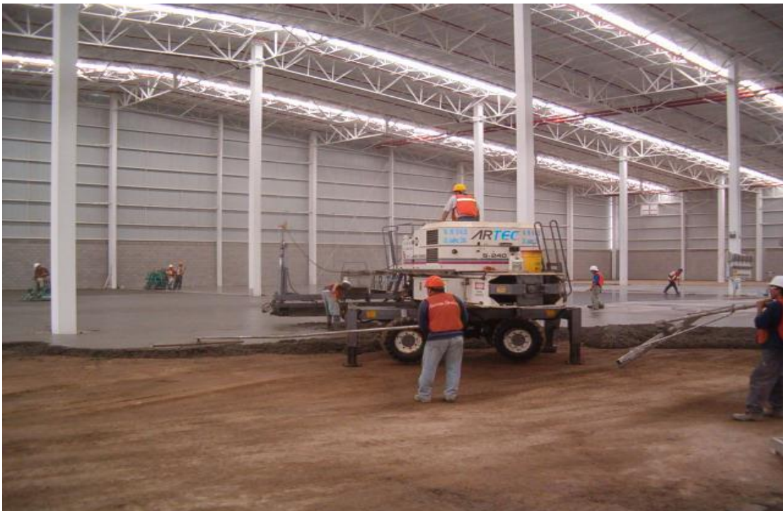
CONSTRUCCIÓN DE PAVIMENTOS RÍGIDO
