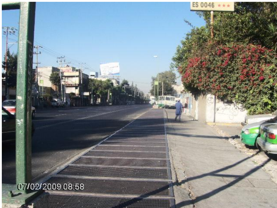
Foto 3. Vista de oriente a poniente (vialidad- morones). Aproximadamente a 2 m. Del lidero del predio de interés existen instalaciones de ventilación del metro
