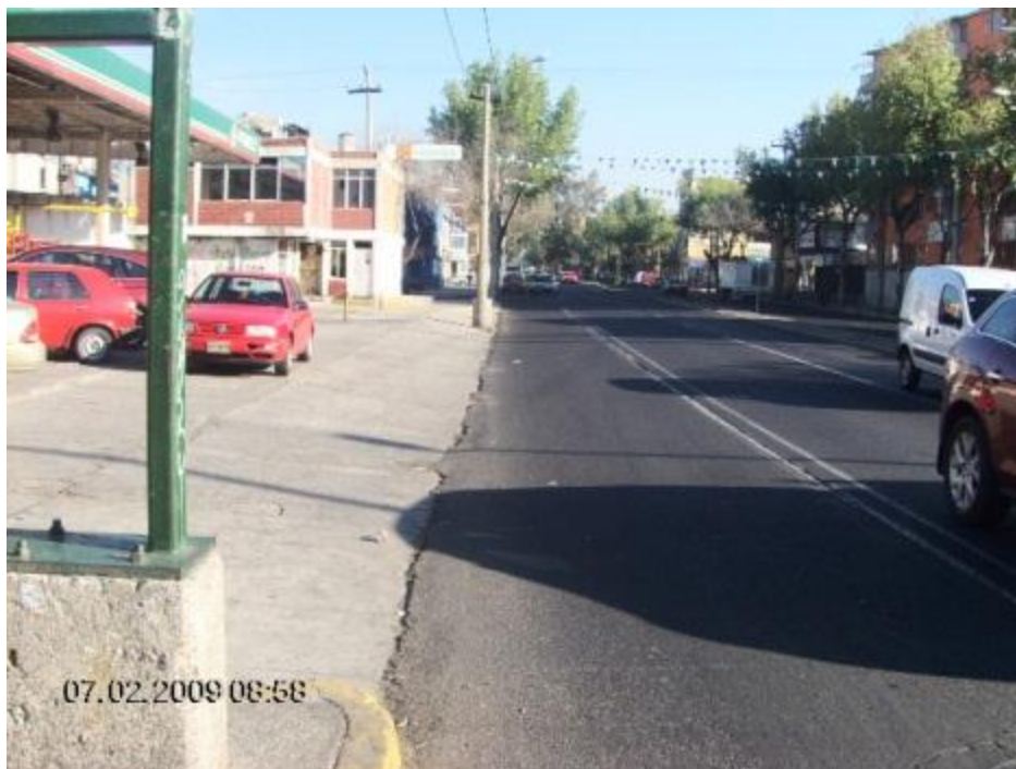
Foto 4 y 5. Vista de sur a norte (vialidad- vertiz). Existencia de grietas sobre el pavimento, a 6 m aprox. Del lindero del predio de interés.
