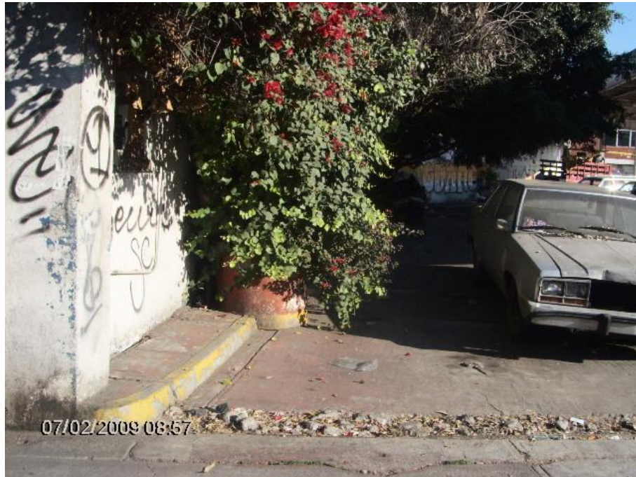
Foto 1. Vista de sur a norte. Junto a esta colindancia existen tanques de la antigua estación de gasolina.
