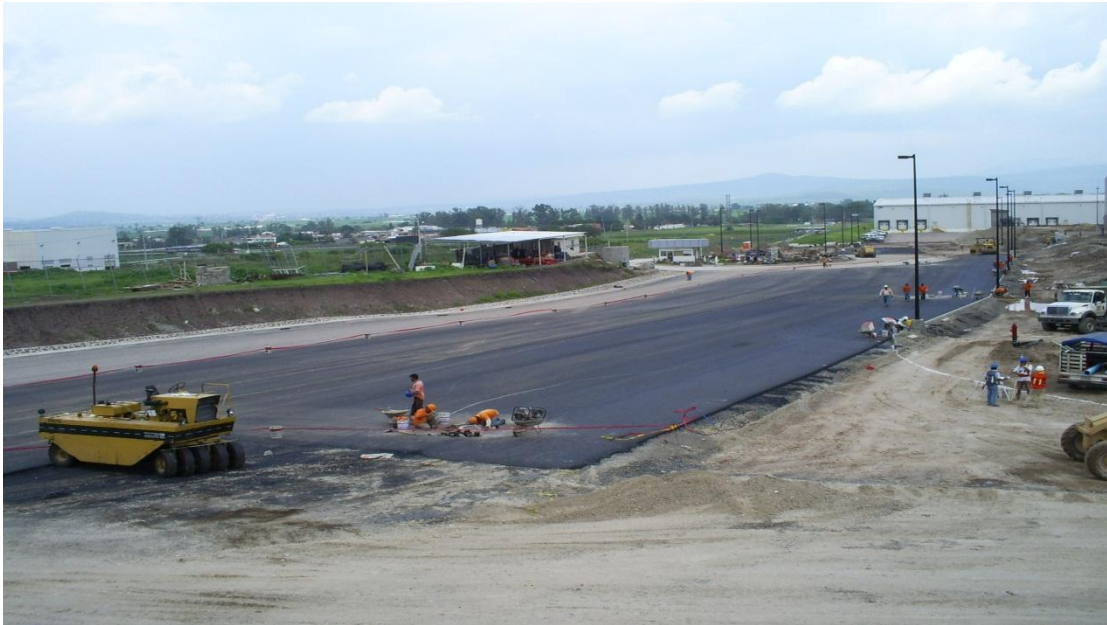
CONSTRUCCIÓN DE PAVIMENTOS FLEXIBLES
