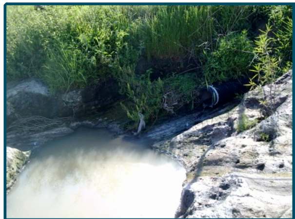
Figura 13. Drenajes que llegan al arroyo.
