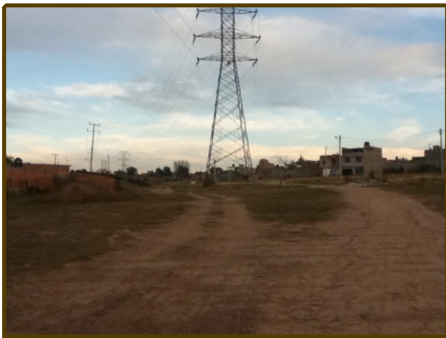
Figura 18. Construcción del nuevo Libramiento San José de las Torres cerca de las colonias.
