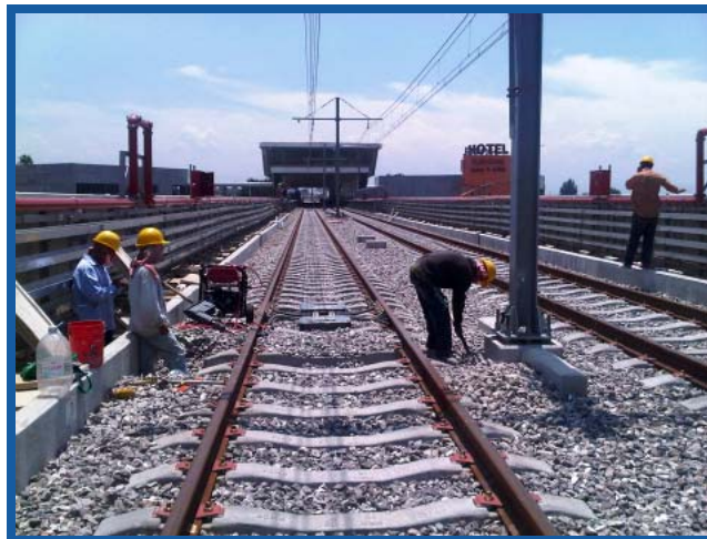
Fotografía del tramo elevado
