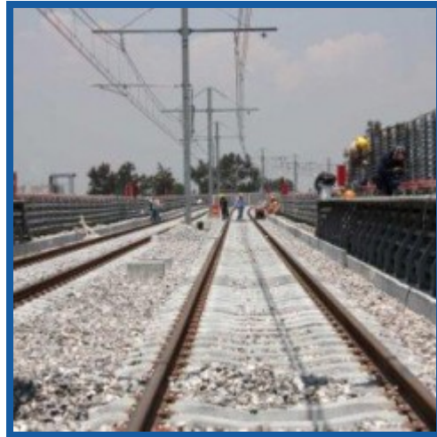
Fotografía del tramo superficial
