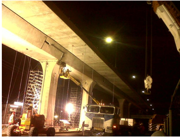
Fig. 3.15 Grúa y polea para prueba de tracción
