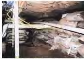
(foto 1.) Costales de tierra en cimentación para evitar hundimientos
