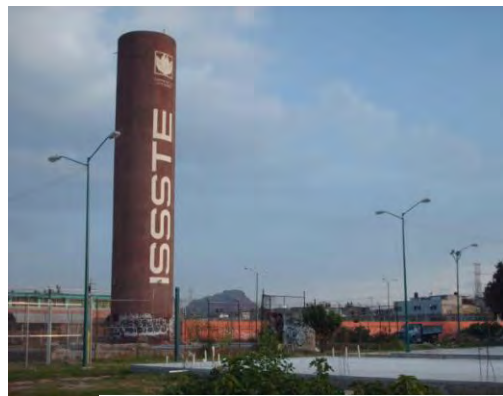
Cisterna y tanque elevado
