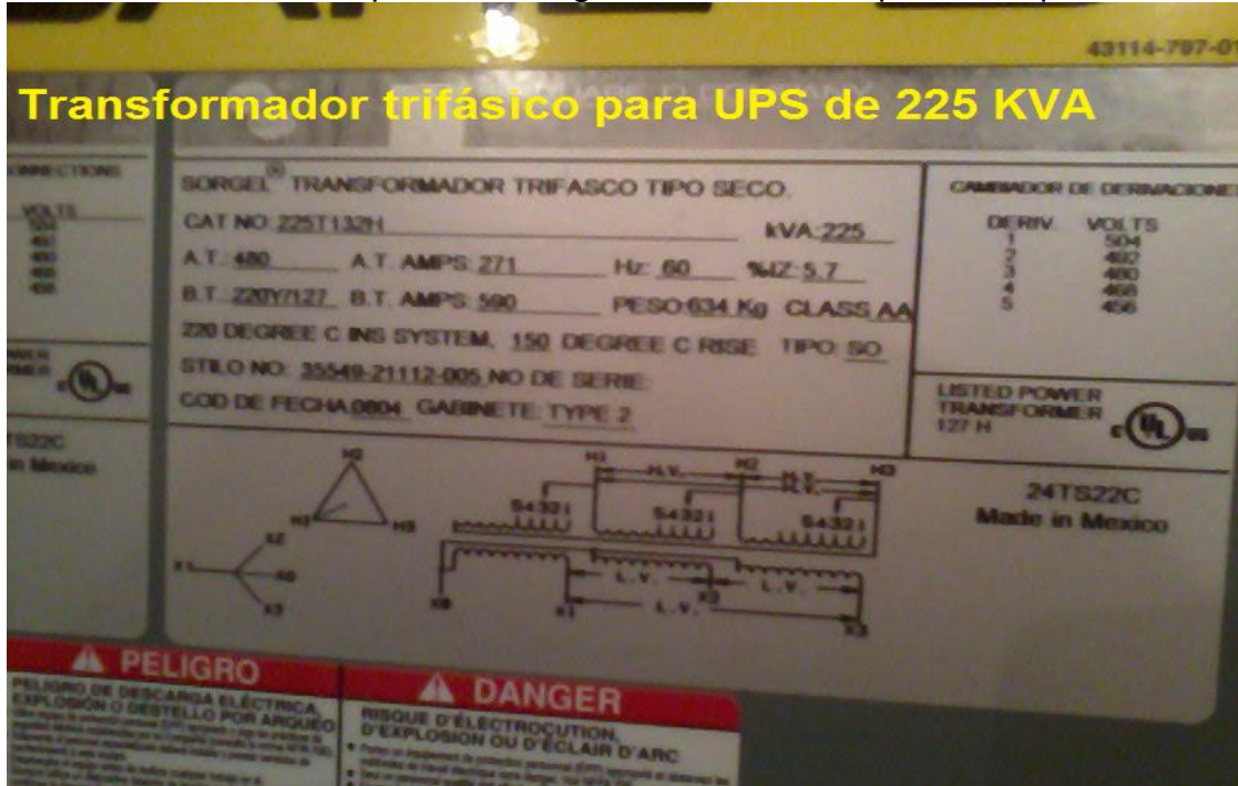
Figura 4.14 Transformador de 225 KVA
