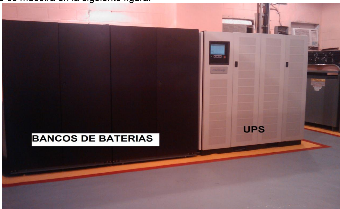
Figura4.13 Instalación de banco de baterías para UPS de 225 KVA
