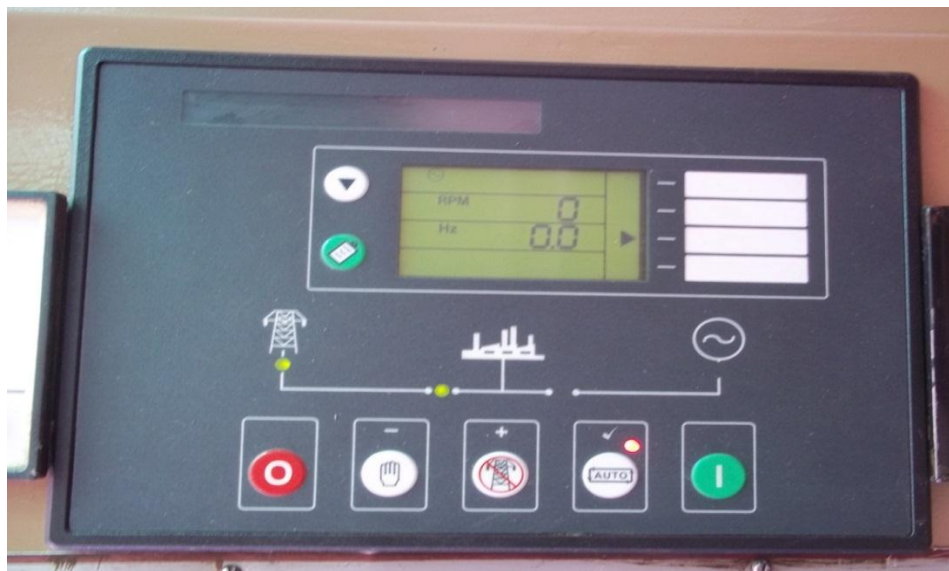
Figura 2.20 Control electrónico basado en microprocesadores
