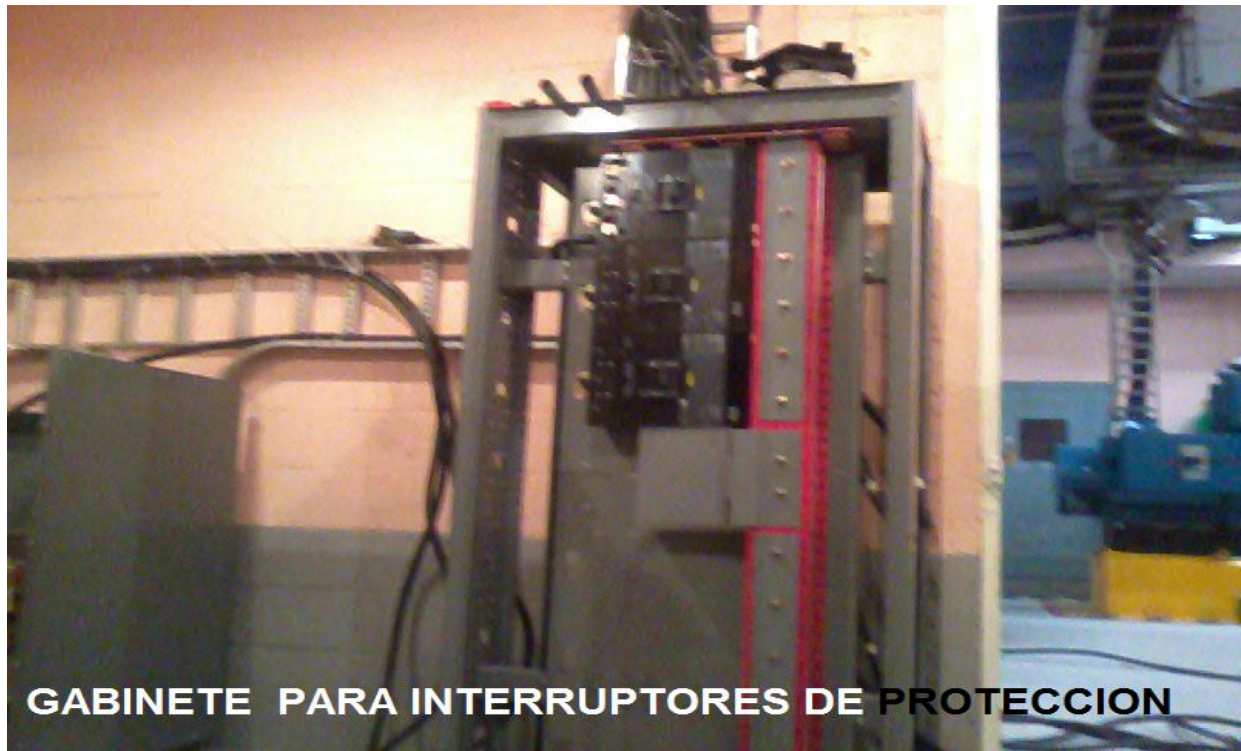
Figura 4.15 Instalación de tablero para UPS 225 KVA
