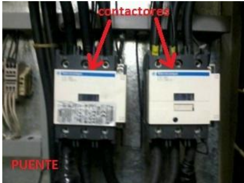
Figura. 2.15 Unida de Transferencia de contactores con puente
