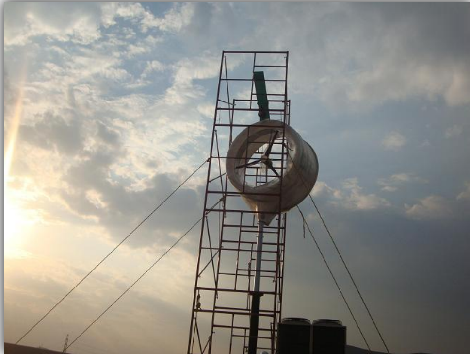
Capítulo 4 Imagen 14 Izamiento del aerogenerador
