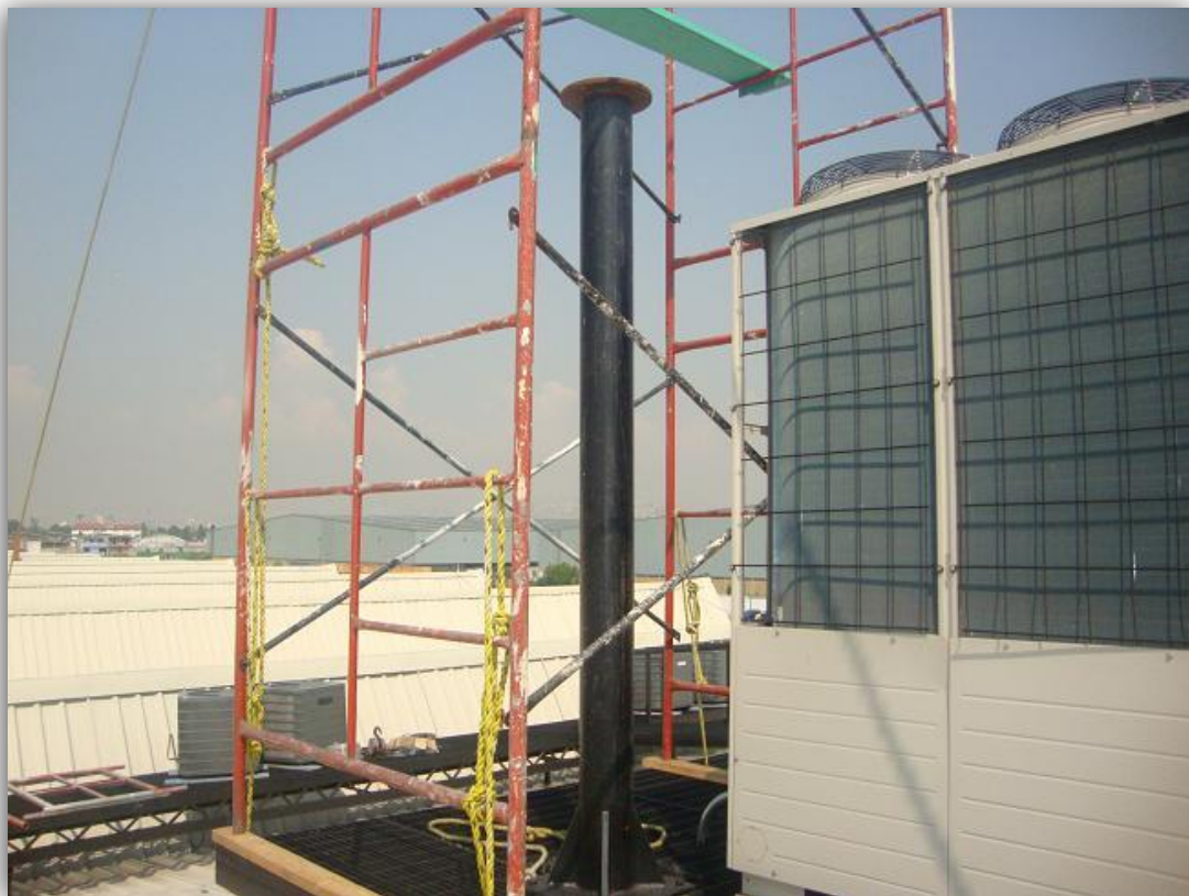
Capítulo 4 Imagen 13 Estructura del andamio
