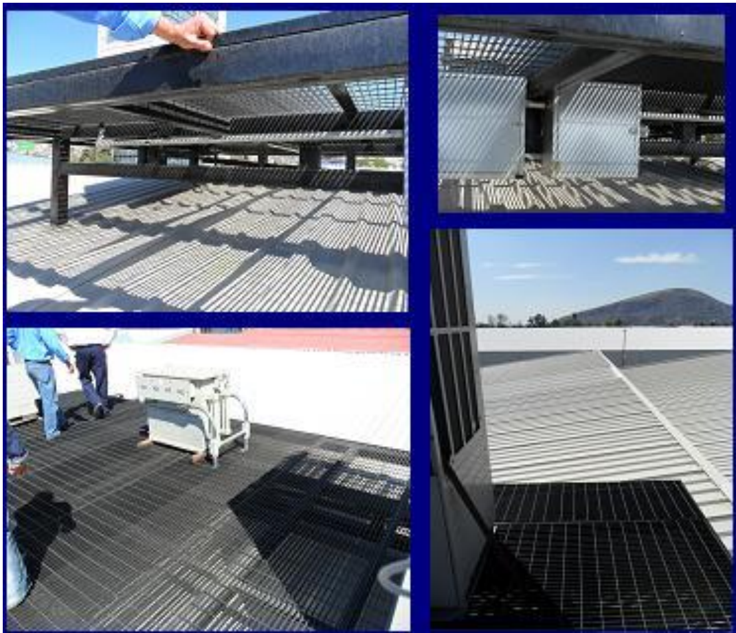
Capítulo 4 Imagen 10 Base de la estructura
