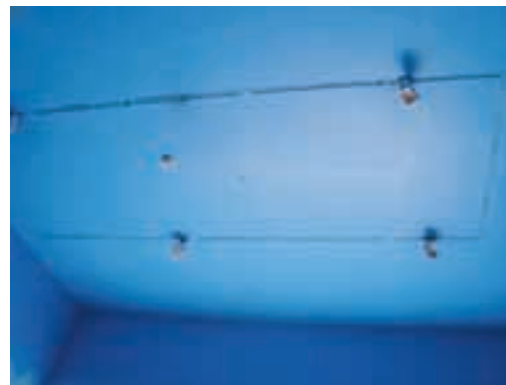
(Ilus.18) Techo del taller e iluminación artificial
