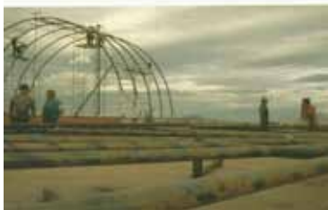
28. Construcción del techado semicircular de uno de los patios del Universum
