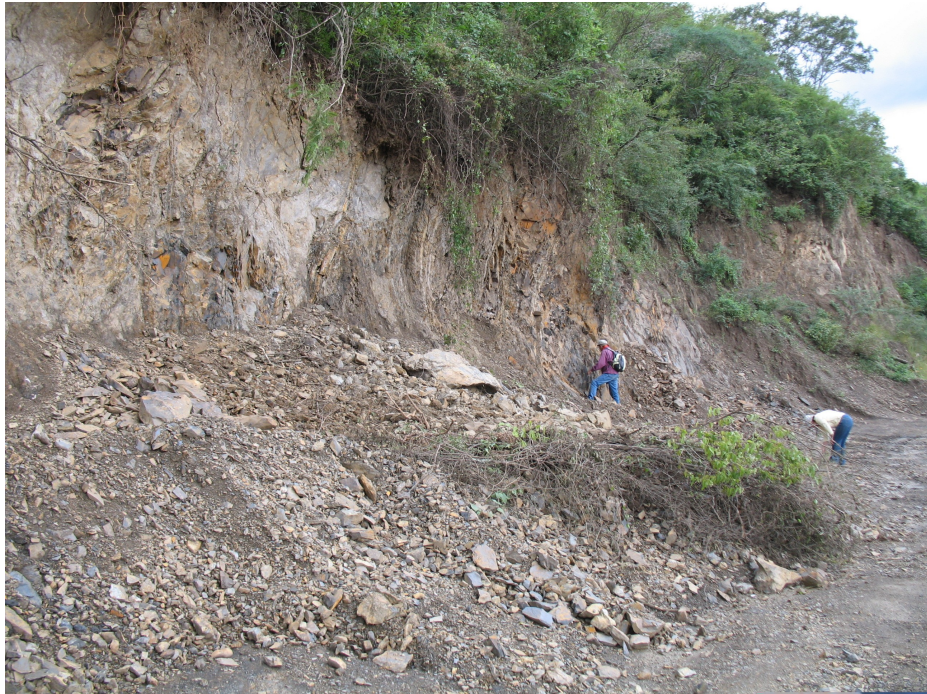
Figura 9. Vista general del afloramiento 3. Se observa la disposición vertical de los estratos.
