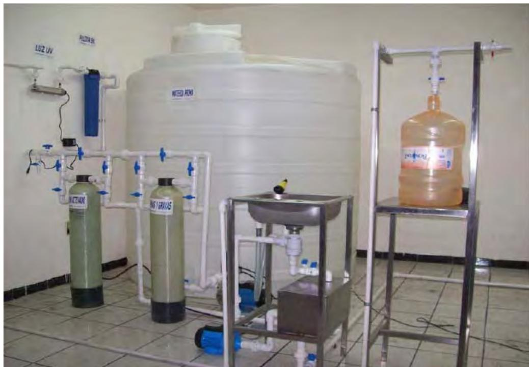
FIGURA 05. Tren de Proceso de Planta Purificadora ECO CELLEN 2.0
