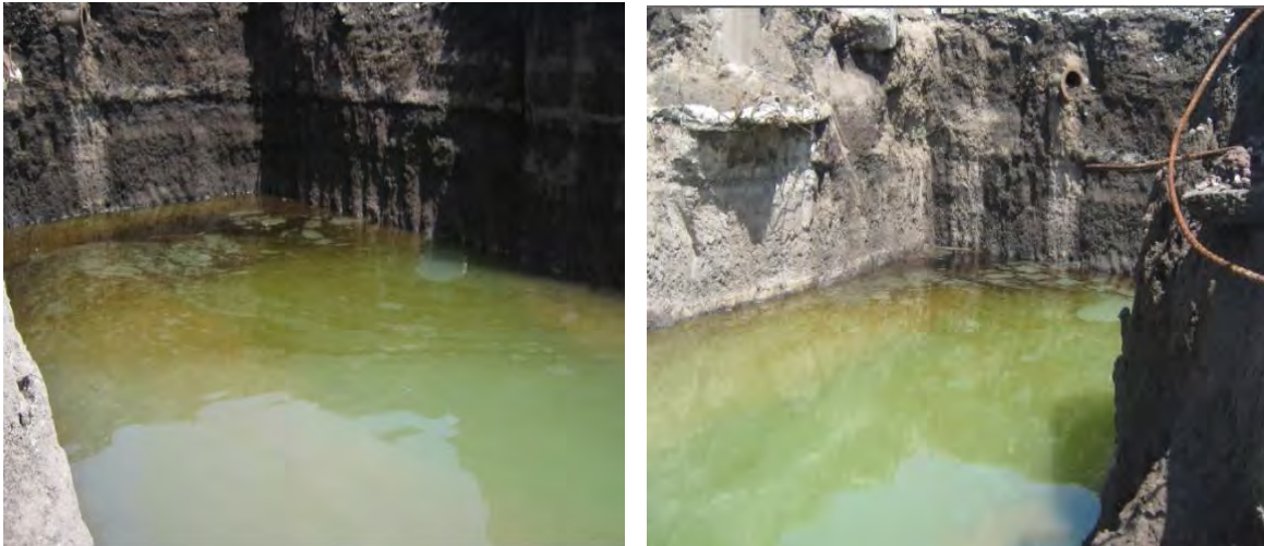
Figura 4.1 Zanja del polígono ZV5
