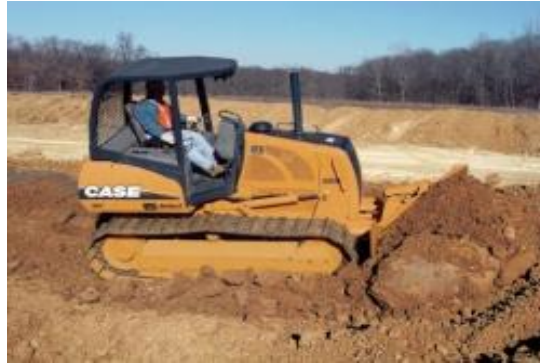
IMAGEN 4-C. Tractor de orugas desplantando terraplén compuesto de material rocoso. Fuente: Foto tomada en obra
