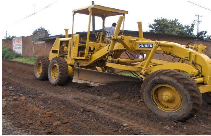
IMAGEN 4-A. Tendido de material mediante motoconformadora. Fuente: Foto tomada en obra
