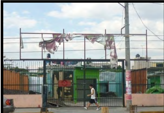
Imagen 22. Vista frontal de la entrada de la plaza 2009
