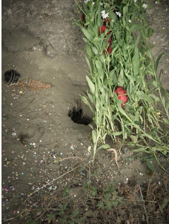
Foto 31. Oquedad al interior de la tierra, altar secundario de templo de "Sto. Domingo", 2006.
