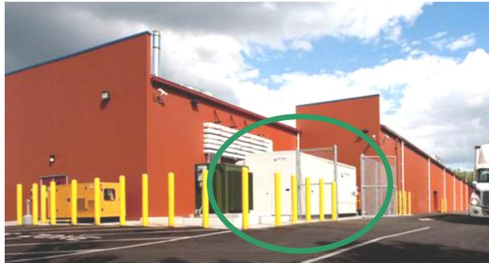
FIGURA 21. CELDA DE COMBUSTIBLE DE 400 kW. PROPORCIONA EL 85% DE LAS NECESIDADES ENERGÉTICAS DE UN SUPERMERCADO. SU USO REDUCE SUS EMISIONES DE CARBONO EN 71 TONELADAS Y AHORRA MÁS DE 4 MILLONES DE GALONES DE AGUA AL AÑO (FOTO TOMADA DEL SUMARIO EJECUTIVO DEL “NEW YORK STATE CLIMATE ACTION PLAN INTERIM REPORT”). FUENTE: “FUEL CELLS FOR DISTRIBUTED GENERATION”, DOE, 2011
