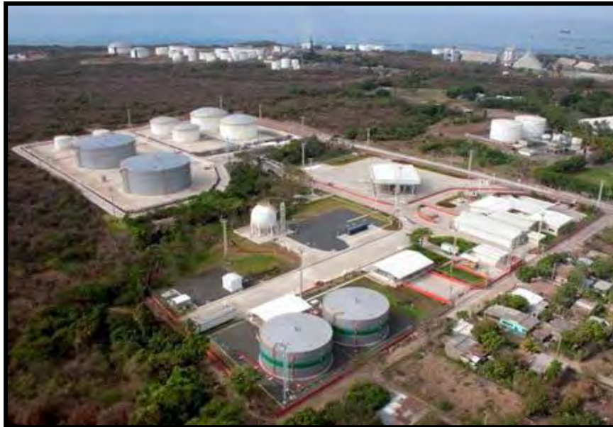
Figura 3.18 De una Central de Almacenamiento y Bombeo en PEMEX. 7
