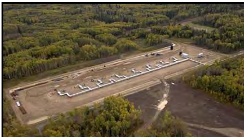
Figura 1.13 Macropera en Texas, etapa de construcción. 7
