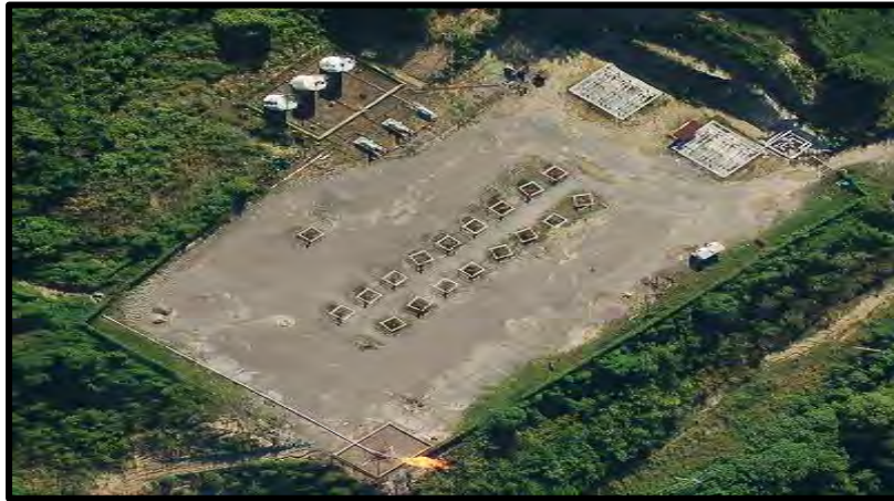
Figura 1.14 Macropera Autosustentable en construcción en al AIATG. 8
