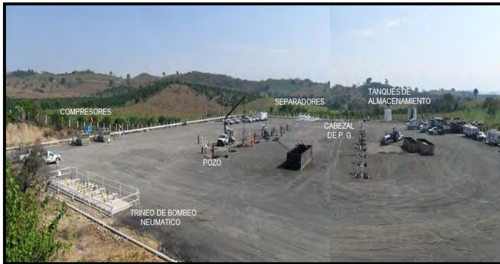
Figura 4.15 Vista de una MPA en construcción dentro del AIATG.
