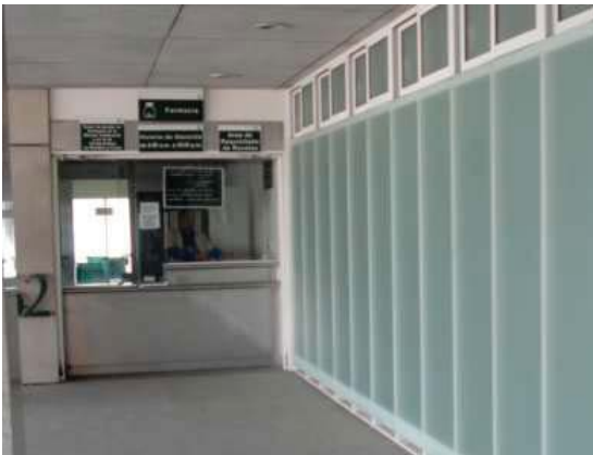
Farmacia; Se localiza en la parte exterior del edificio ahí se entrega el medicamento a cada derechohabiente. Y la recepción de medicamento es por la parte inferior del local.
