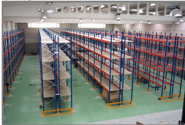
Figura 7.4.4.1. Racks de almacenamiento
