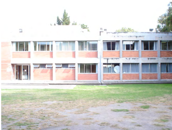
Edificio de metales y percusiones
