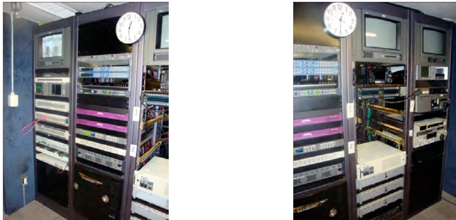
Figura 3-1. En la foto se observan las diferentes máquinas grabadoras y reproductoras como son Betacam SX, SP y XDCAM, así como también los controles del Kaleido y los sincronizadores.
