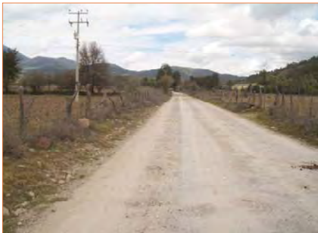
Foto 6.4: se observa un poste de luz de CFE al costado de la carretera.
