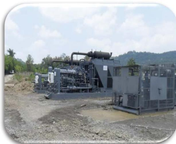
Fig. 17 Motocompresores instalados en Macroperas del campo Chicontepec.
