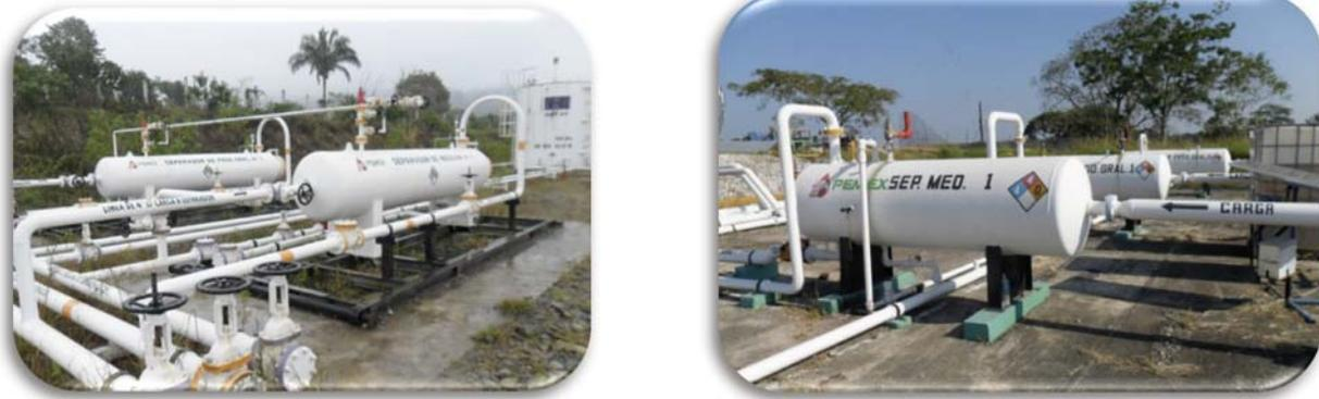
Fig. 13 Separadores de medición y de producción general
