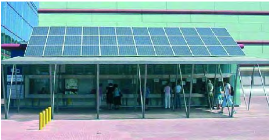
Figura 1.8. Celdas Fotovoltaicas colocadas en el techo de un comercio
