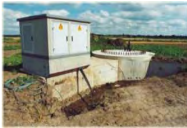
Figura 2.11. Cimentación y transformador de una turbina eólica.
