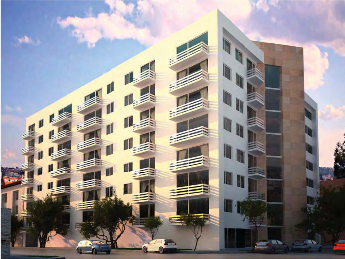
Vista desde la esquina suroeste del edificio.
