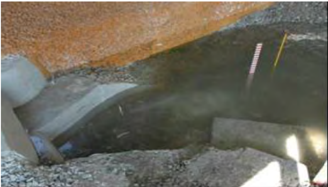
Figura 5.31 Nivel de agua en el desfogue de generación, elevación 422.25\text{ msnm} (Laboratorio de Hidráulica, CFE, 2007)
