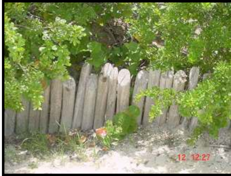
Figura 36. Barreras a poner en la zona de dunas de Playa Larga para evitar el paso de la arena a Laguna Larga.
