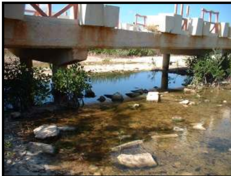
Figura 39. Sector a limpiar debajo del puente de acceso a Playa Larga en la zona central de Laguna Larga.
