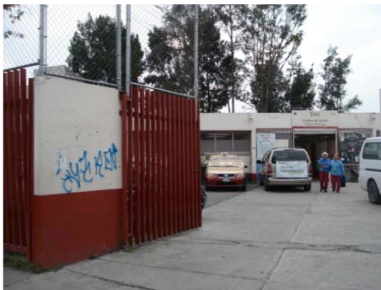
Foto 6. Centro de Salud Urbano T3 Miguel Hidalgo Jurisdicción Sanitaria Tláhuac.
