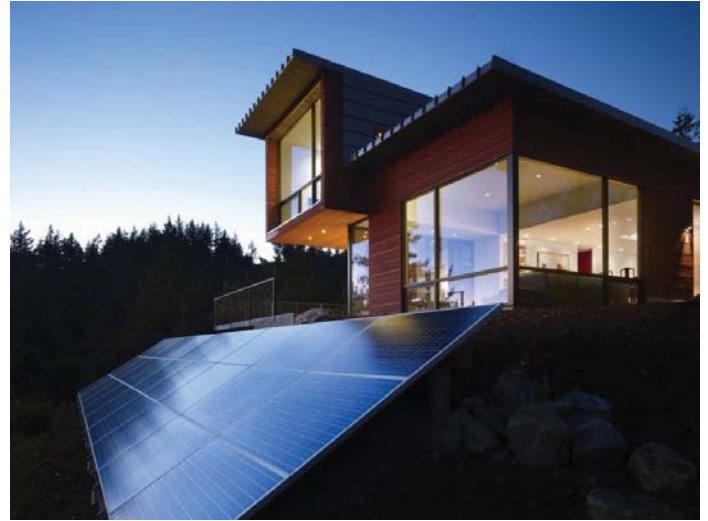
Cabaña de verano en la Montaña. Uso de paneles solares . Washington Lake. Prentiss Architects. http://www.defachadas.com/fachadas-modernas/
