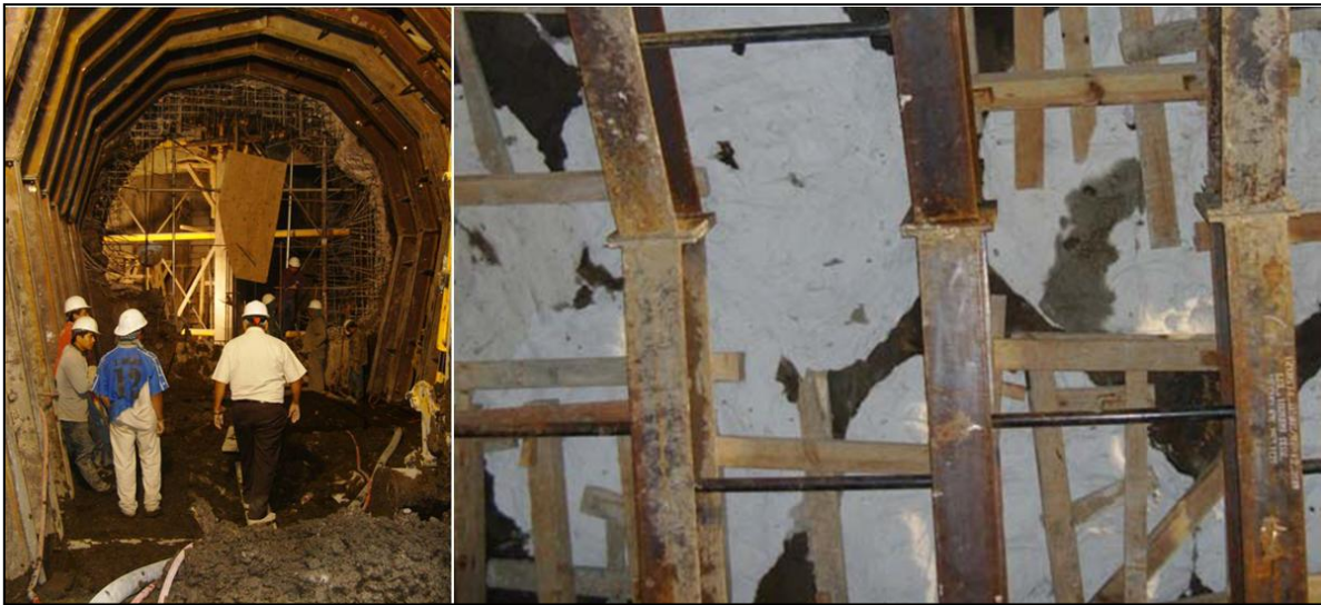
Figura 23.- En la fotografía de la izquierda se muestra un túnel al cual, para su avance, se recurrió al mejoramiento del suelo por medio de jet grouting. En la foto de la derecha, se muestra precisamente una vista mostrando la clave donde se aprecian los arcos metálicos y por encima de ellos, se alcanzan a ver las columnas cortadas, tangentes en este caso, del mejoramiento por jet grouting. Ambas fotografías corresponden al túnel de interconexión de los Cárcamos 1 y 2 con la Lumbrera 04 del Túnel Río de la Compañía.
