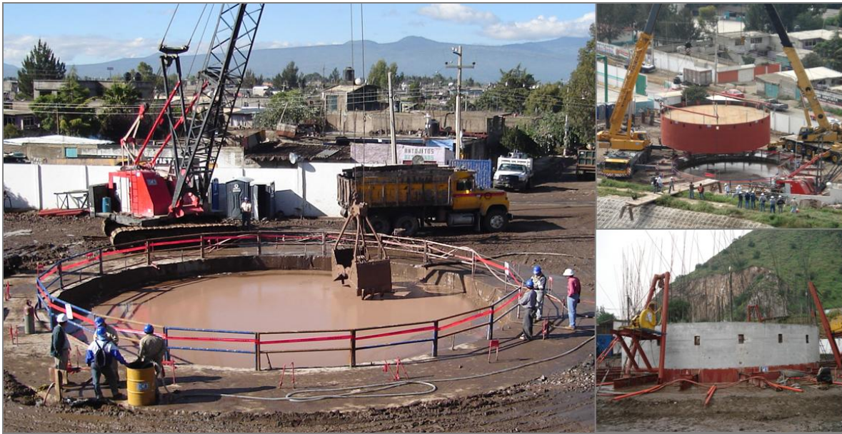
Figura 4.- Construcción de una lumbrera flotada. En la foto de la izquierda se observa la excavación del núcleo inundado con lodo bentonítico; arriba a la derecha se observa el posicionamiento del tanque de flotación; abajo a la derecha se puede ver el tanque de flotación ya parcialmente sumergido y encima de éste la construcción de muros de concreto reforzado como revestimiento. Posteriormente se irá sumergiendo hasta llegar a la profundidad deseada. La lumbrera que se ilustra corresponde al Túnel Río de la Compañía.
