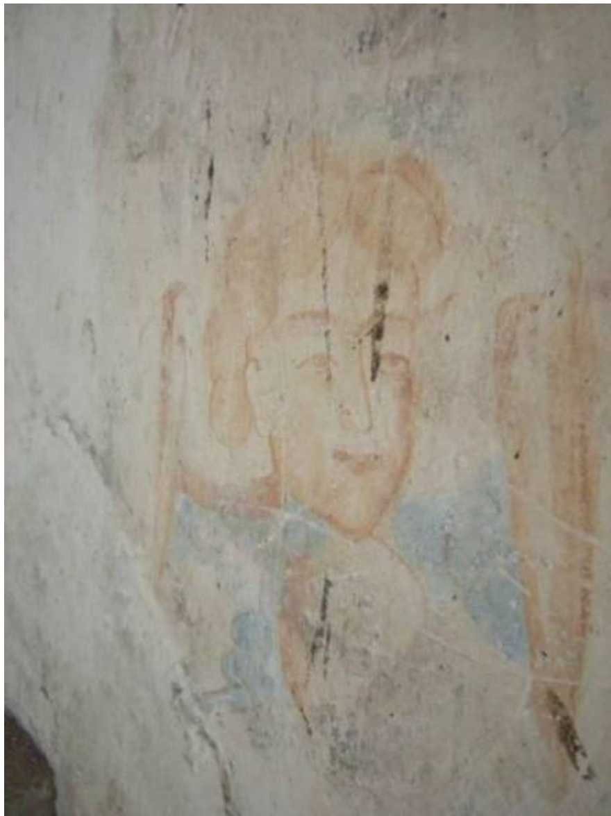
32. Detalle de la arquivolta que rodea la escena de la Asunción, muro 1 del ábside de la iglesia, convento de Santa Clara de Asís, Dzidzantún, Yucatán, septiembre, 2009
