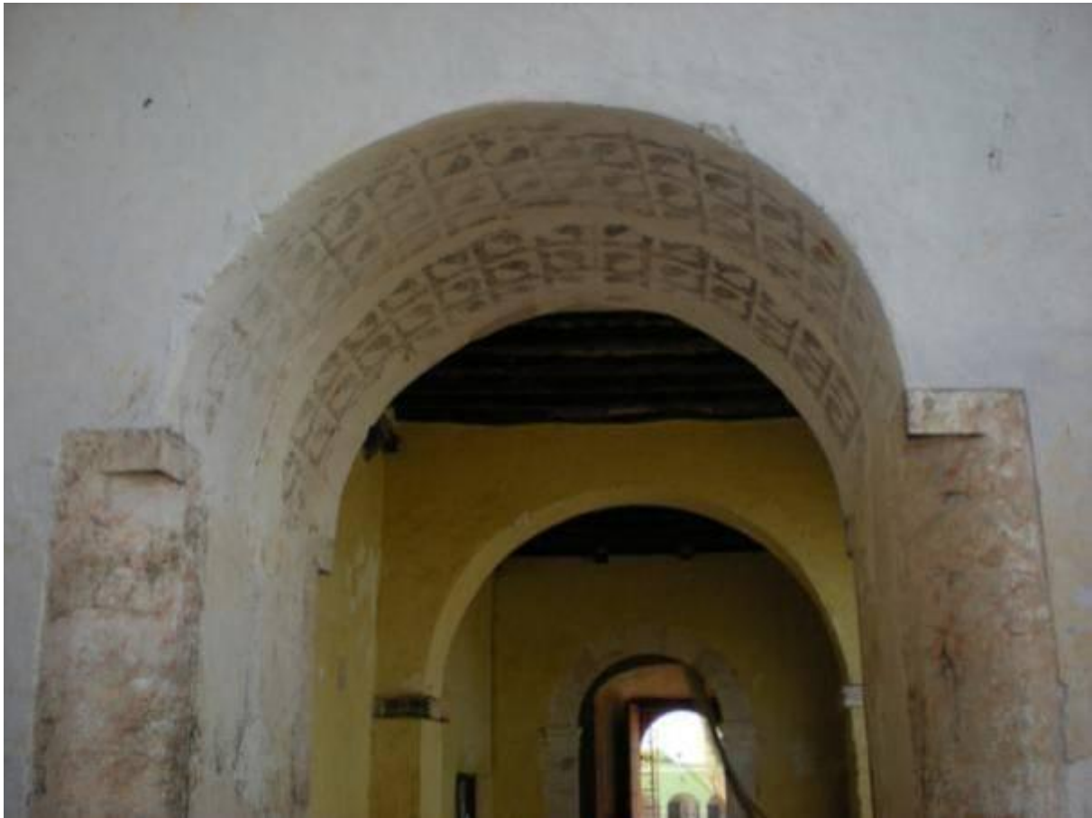
63. Decoración geométrica en el arco y restos de las franjas que simulan mármol veteado en las columnas que sostienen el arco que comunica la capilla abierta con la portería, convento de San Miguel Arcángel, Maní, Yucatán, diciembre, 2008
