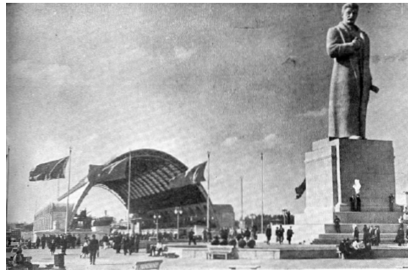
7. Moscú - Exposición Agrícola de la U.R.S.S. - 1939-1941. Pabellón de la Mecanización (Arq. I. Iálanov y Arq. V. Ardreiev) - Escultura "I. Stalin" de Mercurov.
