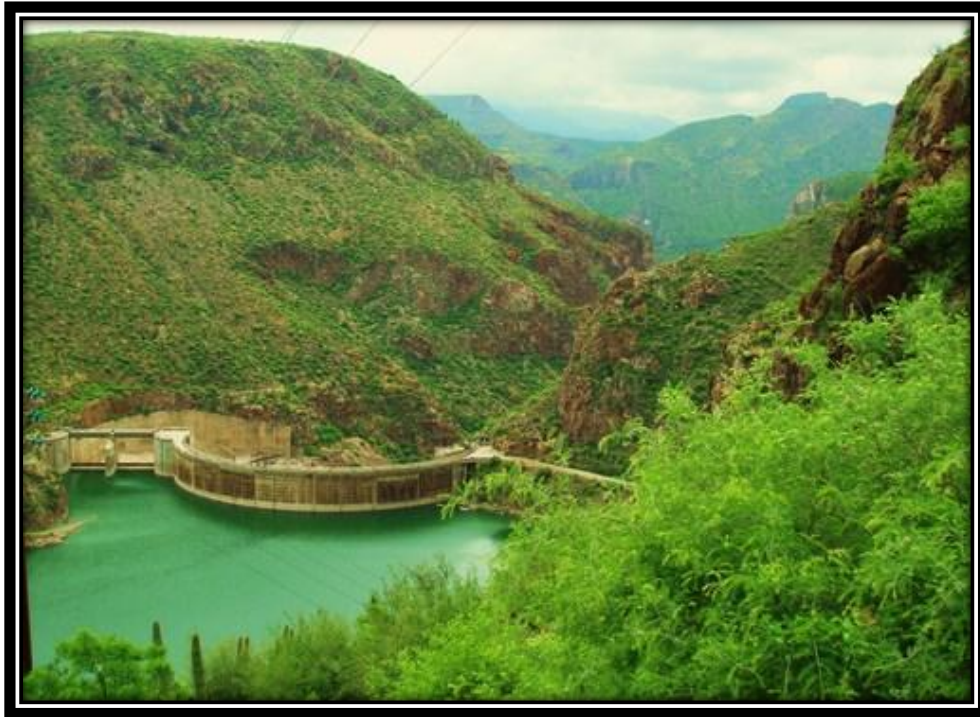
Figura III-2. Vista de la presa La Angostura, Son
